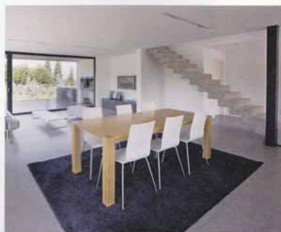
Der gewachste Sichtbeton der Faltrittrepp im EG ergibt zusammen mit dem gewachsten Steinboden einen loftartigen Charakter.
