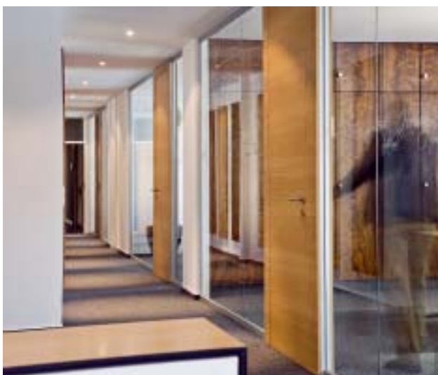
Büros im OG sind zum Flur hin mit Glastrennwänden transparent geschlossen, ergänzt von Türen in Eiche.
