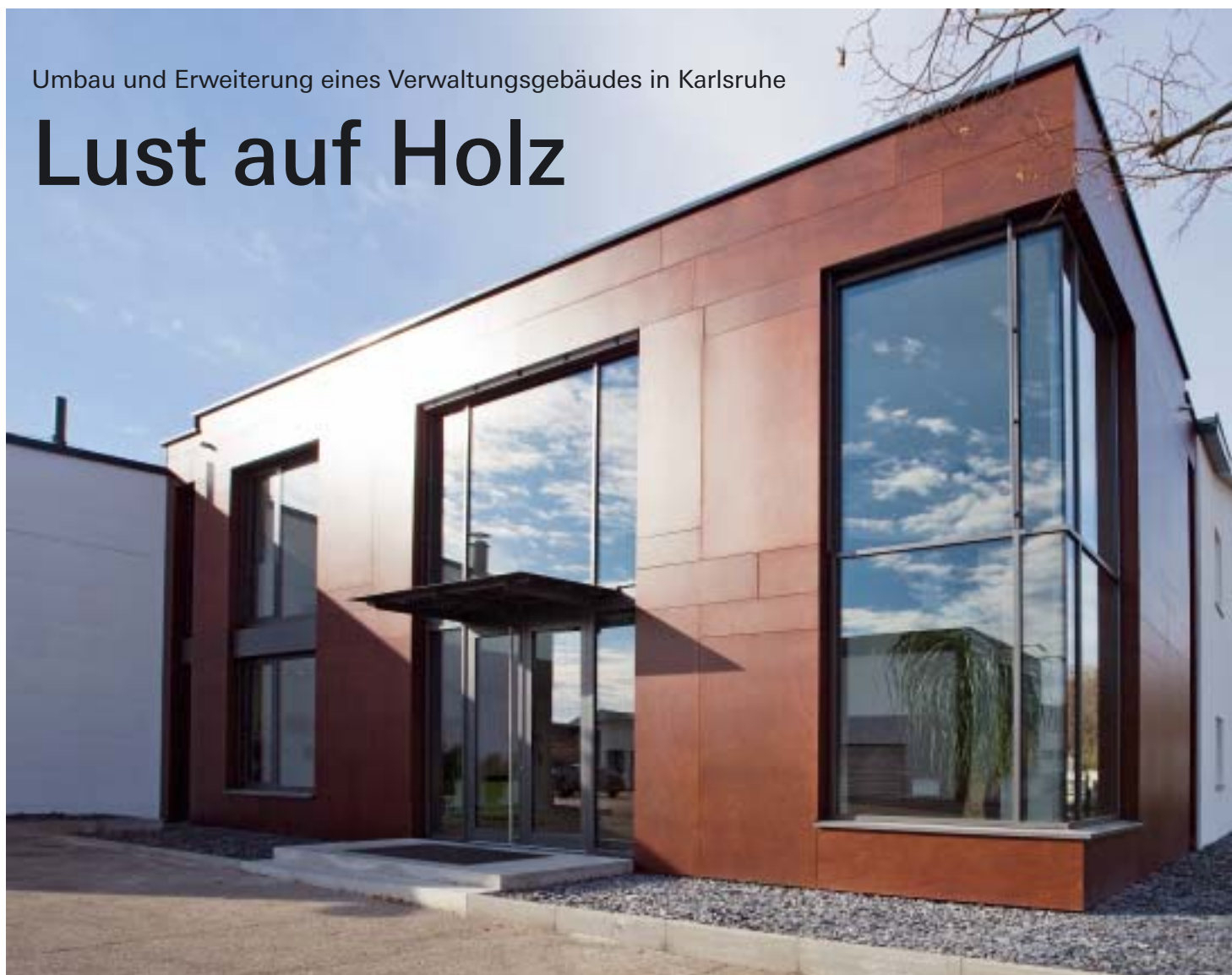
Neubau mit Fassadenplatten aus afrikanischem Okumé-Schäl furnier.
