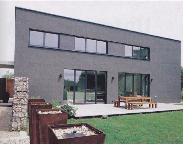
**Abgeschirmt:** Eine Mauer aus Gabionen (steingefüllten Stahlgitterkörben, li.) schützt vor Blicken von der Straße.
